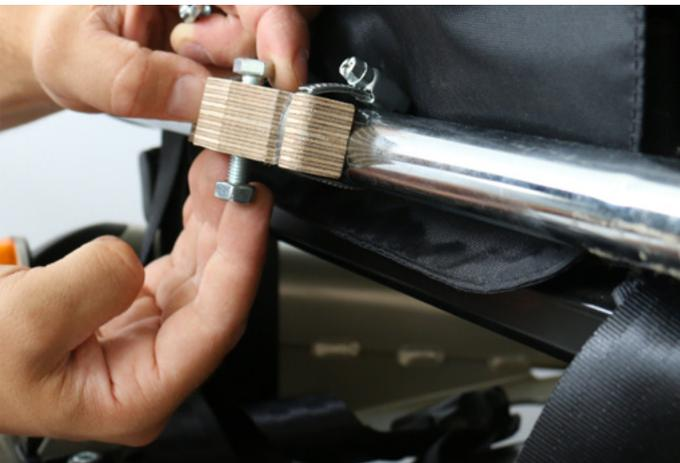
Setze die Sechskantschraube in die Öffnung schraube die Mutter fest.
